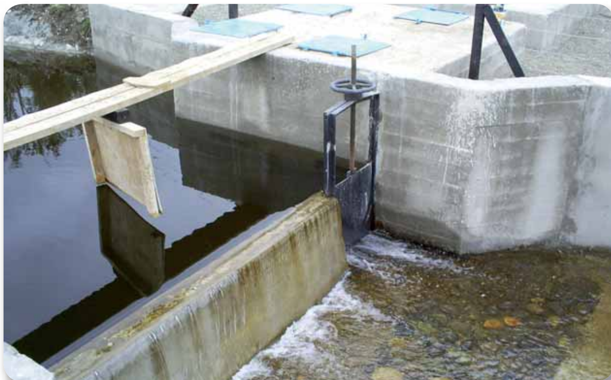
Instalación Sistema de Agua Potable Rural. Curanue, Región de Los Lagos.
