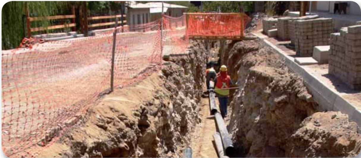
Construcción Sistema de Alcantarillado. Río Hurtado, Región de Coquimbo.
