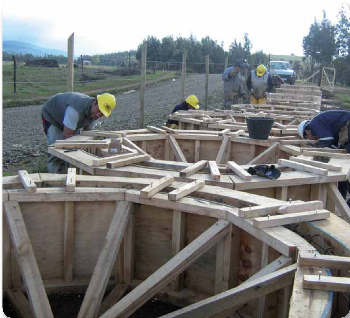
Instalación de Sistema de Agua Potable Rural, Maica Alto y Bajo, Región de la Araucanía.
