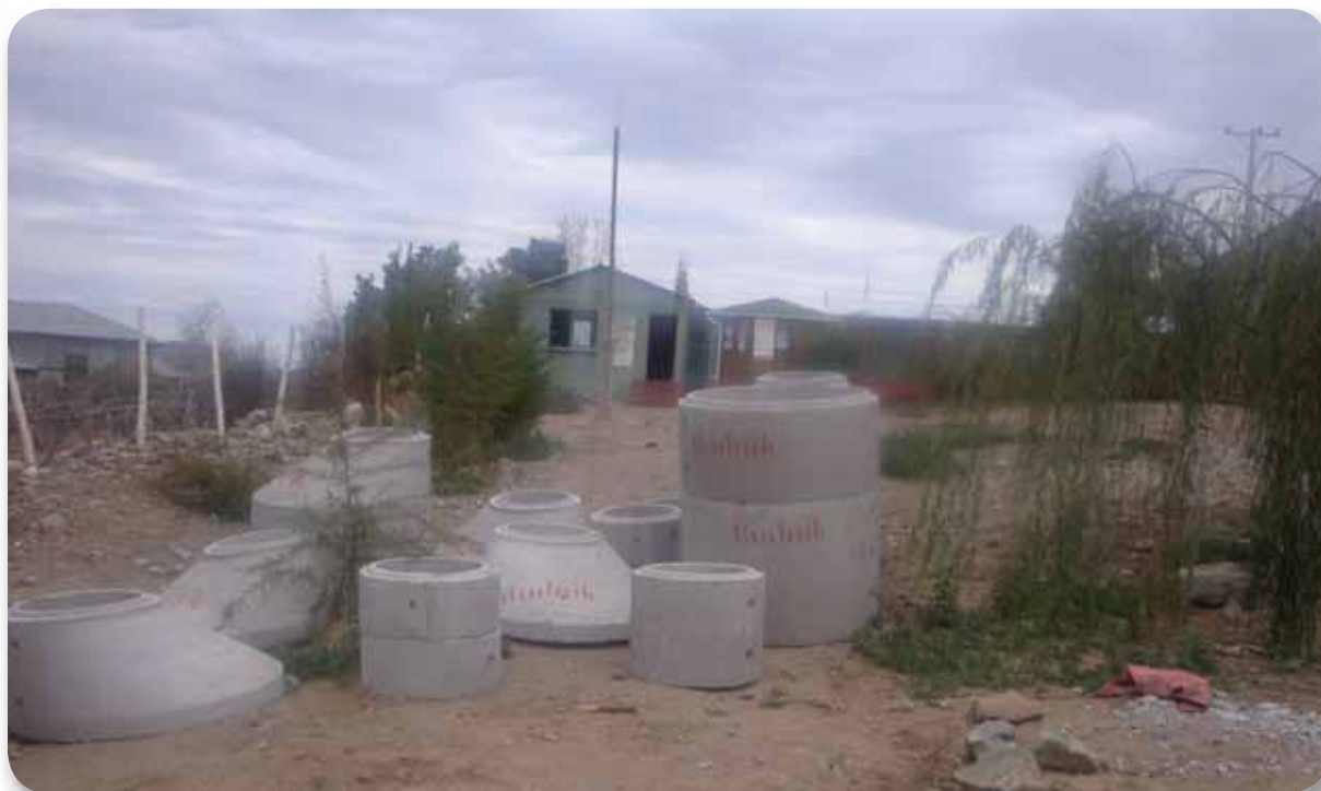
Construcción sistema de alcantarillado. Rio Hurtado, Región de Coquimbo.
