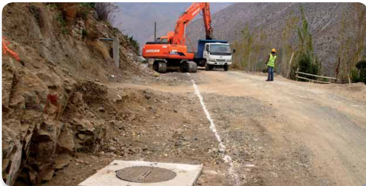
Construcción Sistema de Alcantarillado. Río Hurtado, Región de Coquimbo.
