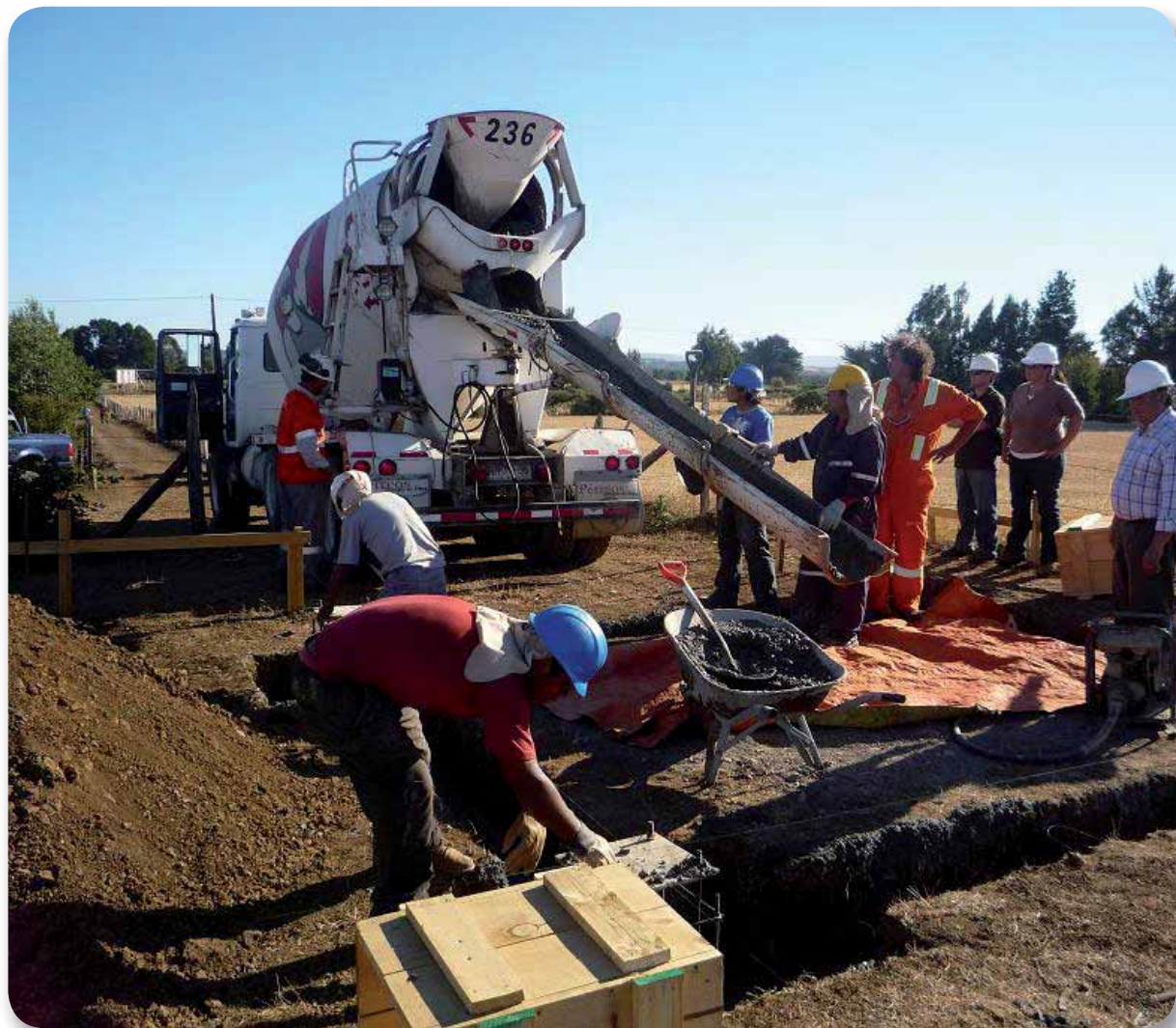
Instalación del Servicio de Agua Potable Rural de Trihueche. Nueva Imperial, Región de La Araucanía.
