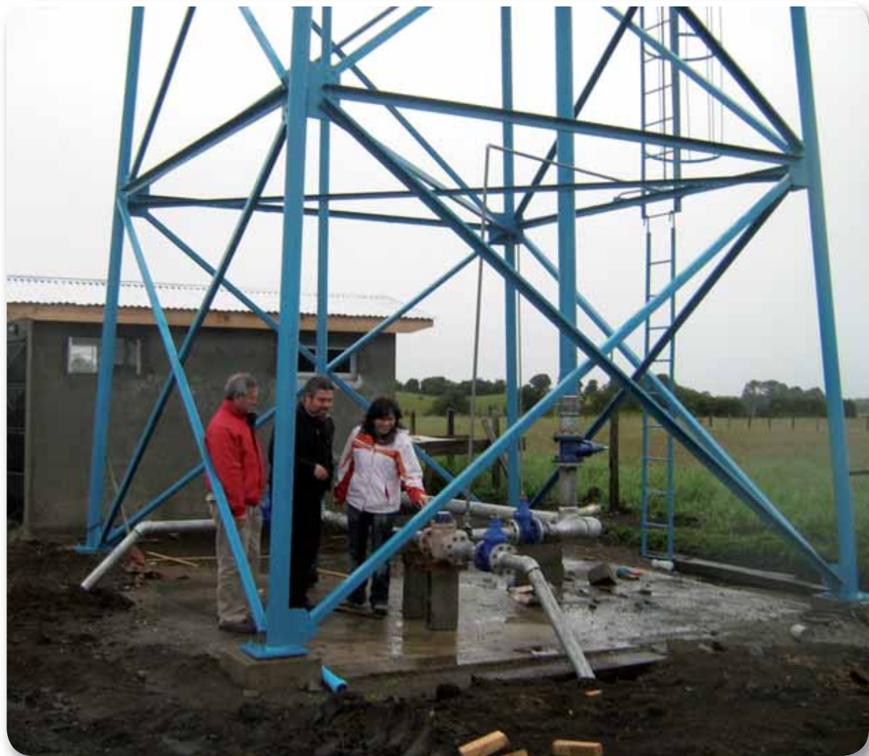
Instalación del Servicio de Agua Potable Rural de Castro. Chonchi, Región de Los Lagos.
