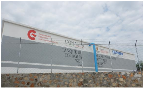
Fotografía 1: Tanque de distribución de agua construido para la mejora del servicio.
