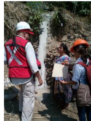
Fotografía 4: Certificación de sistema de Alcantarillado Condominial, Barrio 2. San Marcos La Laguna, Sololá.
