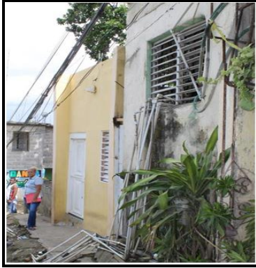
Sistema actual de abastecimiento de agua por pozo de agua subterránea privado - Cancino Adentro, SDE - 11-2015
