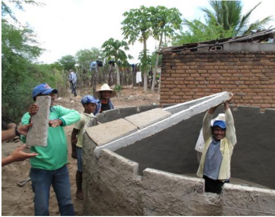
Proceso de construcción de una cisterna
